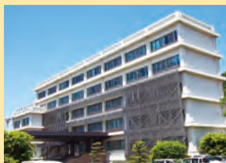
改修工事が完了した愛媛大学本館棟
