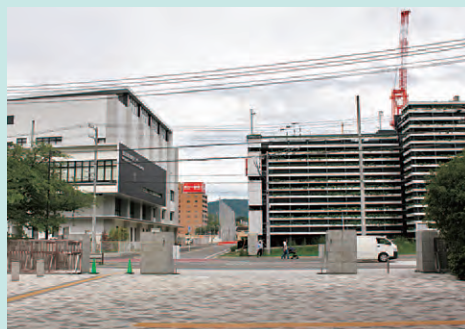
松山市教育研修センター(左)と日赤立体駐車場 (学内から正門を東へ向かって撮影)
